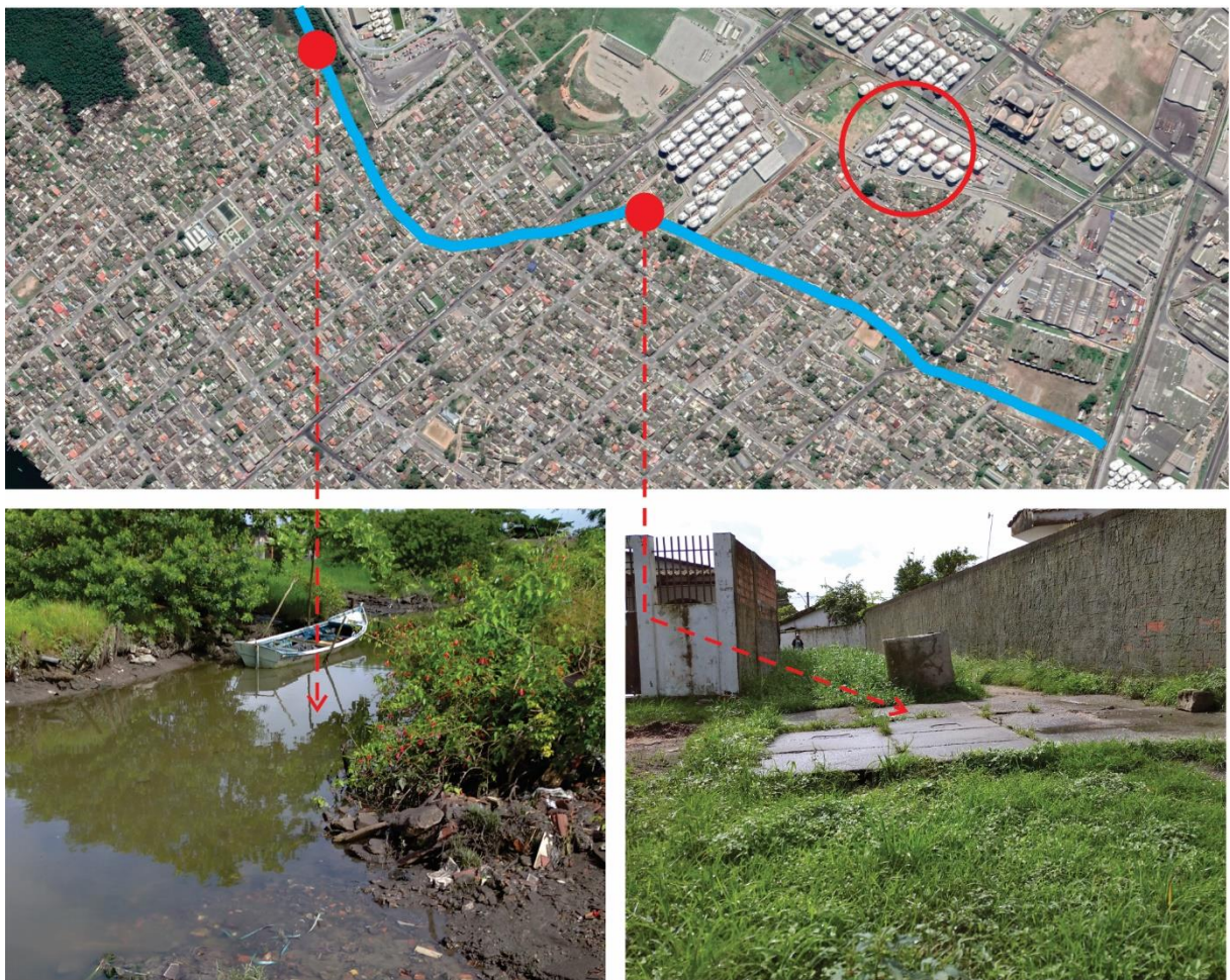
Figura 30: Canal do Anhaí na região do empreendimento.
