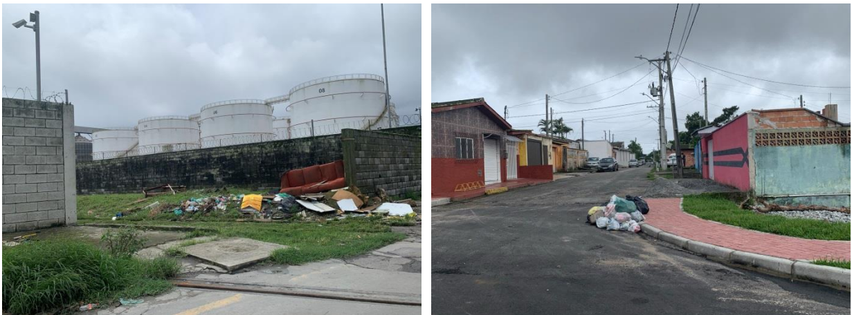
Figura 44: Disposição inadequada de resíduos na AID.
