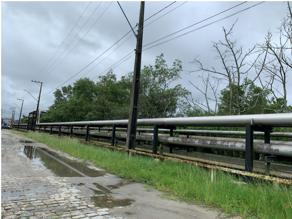
Figura 5: Duto em direção ao píer público de inflamáveis.
