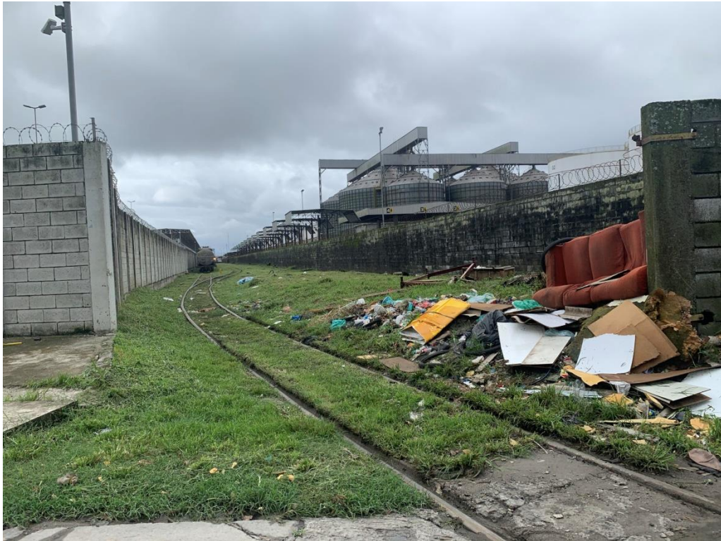
Figura 51: Linha férrea na Rua José Cadilhe.
