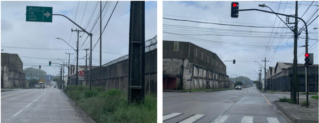
Figura 54: Avenida Bento Rocha.
