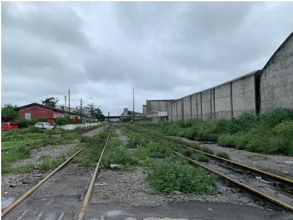
Figura 52: Linha férrea na Avenida Coronel Santa Rita.
